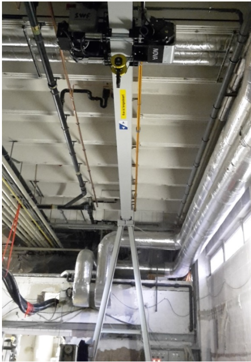
Bild 8 – Montagekran für Eisspeicher
