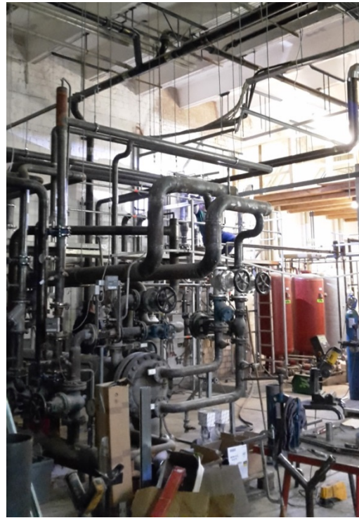
Bild 9 – Umbau Heizungsverteilung
