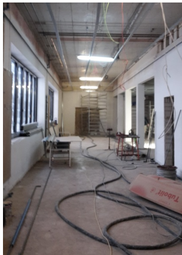
Bild 2 – Nördlicher Flur EG
