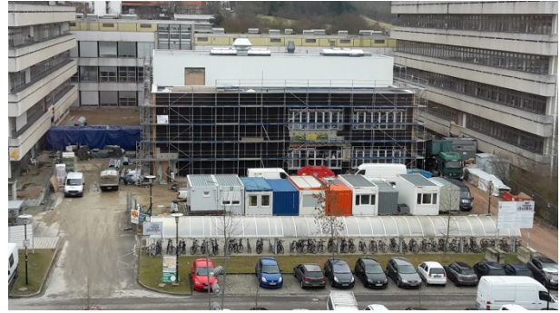
Bild 7 – Ansicht Baustelle von der Physik
